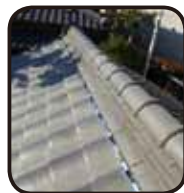
⑥工事完了
