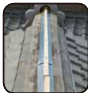
④補強部材取付
